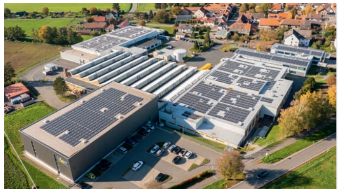
Mit gesellschaftlicher Verantwortung und Fotovoltaik auf den Dächern: Die Unternehmenszentrale liegt im südhessischen Ober-Ramstadt.
